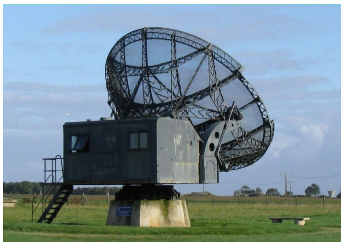
Ci-dessus, radar allemand de conduite de tir Würzburg-Riese installé à partir de 1943, mobile en azimut et en site d'une portée efficace d'environ 70 km. La coupole est depuis tombée par suite d'une tempête et de la corrosion. Photo. JMT sept. 2015
